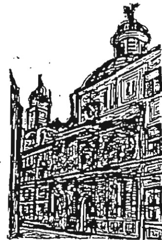
Italienische Renaissance auf dem Kapitelplatz -
